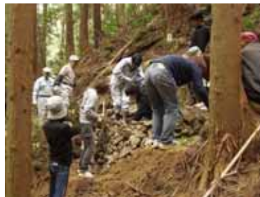
遍路道修復のボランティア作業
